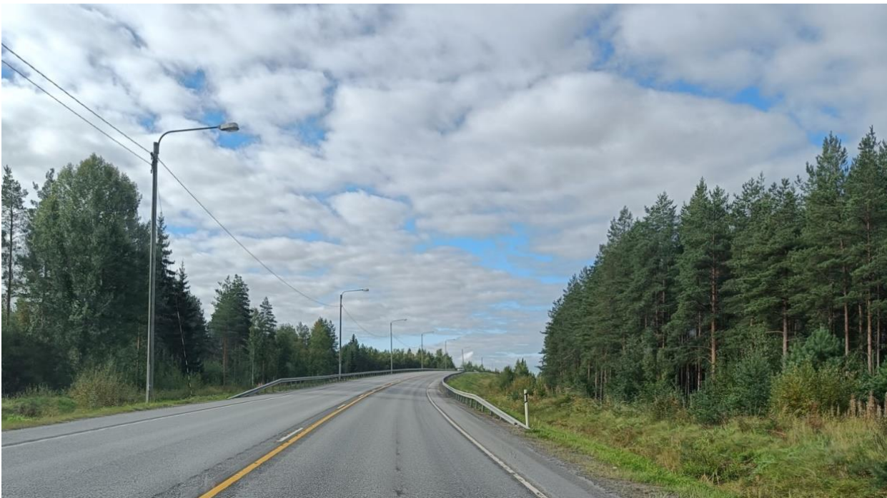
Kuva 1. Kokkolan ratasilta selvitysalueen pohjoisosaan.
