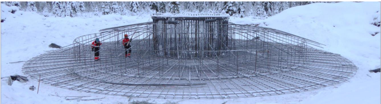
Kuva 1: Tuulivoimalan perustuksen raudoitus
