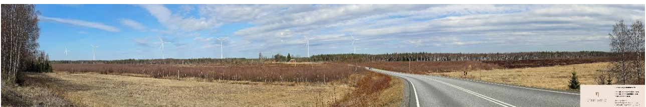
Bild 10.44. Visualiseringsbilder från Kivijärvi. Landskapet tillförs ett nytt, mänskligt modifierat skikt. Alla 6 kraftverken syns tydligt från fotograferingsplatsen. Vid fotograferingsplatsen förändrar projektet landskapet avsevärt. Konsekvenserna för landskapet är betydande vid fotograferingsplatsen.
